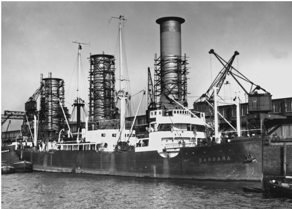
Das zweite Rotorschiff, die BARBARA, im Bau bei der AG Weser, 1926. Foto: Archiv DSM
