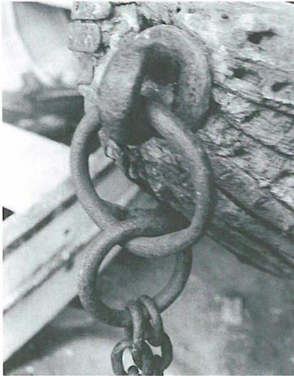
Abb. 14 Festmachring mit Eisenbolzen und Kette.
