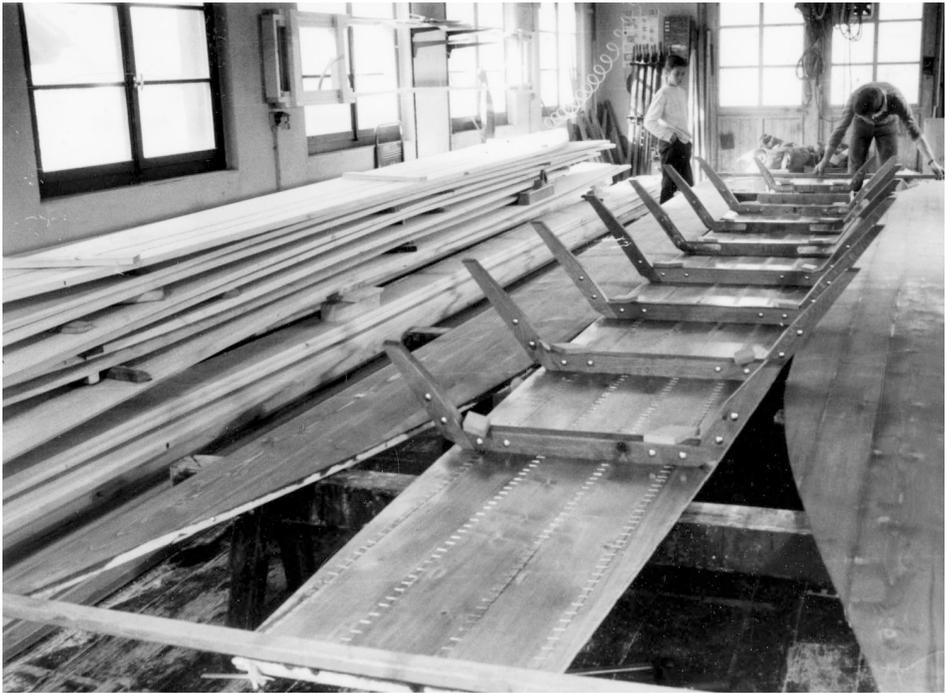
Abb. 10 Die mit Leiste und Klammern, den sog. Agraffen, abgedeckten Fugen zwischen den Bodenplanken eines Weidlings in der Werkstatt des Weidlingbauers Hans Waldmeier in Mumpf wecken die Vorstellung, dass das Boot »genäht« worden ist. (Foto: Roemari Spycher-Gautschi/Archiv DSM)
