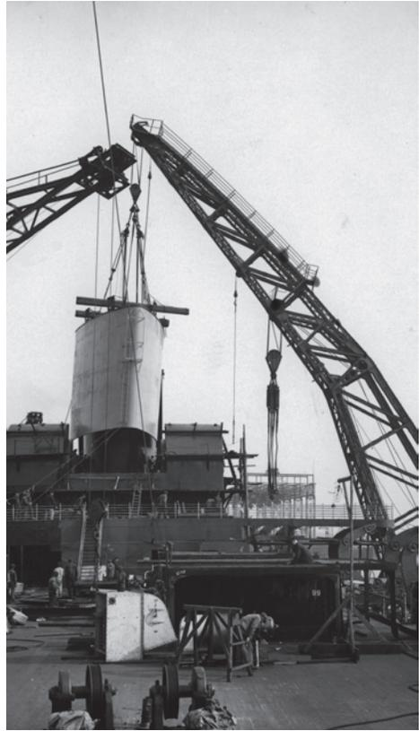
Abb. 14 Montage des Schornsteins der BREMEN, 1928.
