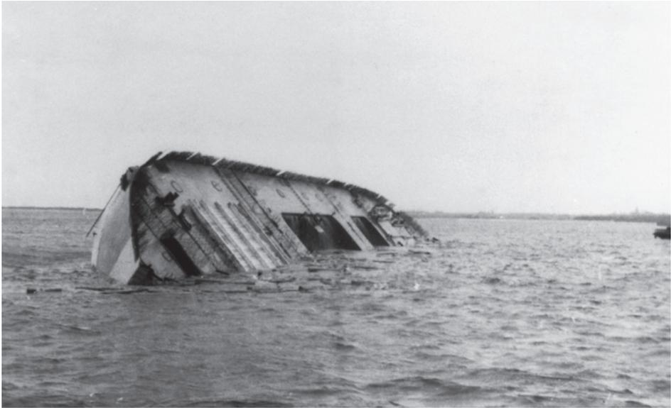
Abb. 22 Die kritische Phase des Drehvorgangs ist überstanden und die Gefahr des Volllaufens gebannt. Die Schalungen in Luke 1 und im Maschinenschacht haben dem Wasserdruck standgehalten. (Werksfoto Dyckerhoff & Widmann/Archiv DSM)
