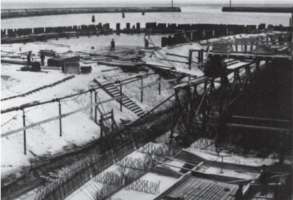
Abb. 11 Baugrube für den Bau von Betonschiffen in Rügenwaldermünde (Darłowko) im November 1942. Zu erkennen ist die Deckplatte der Bau-Nr. 1, der späteren ULRICH FINSTERWALDER. Noch während des Baus der ersten Grube begann man im Sommer 1942 mit dem Aushub der zweiten Grube, deren gerammte Spundwände zu erkennen sind. Im Hintergrund die Molen, die die Wippermündung schützen. (Slg. Gerhard Janke/Archiv DSM)
