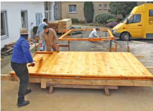
Bau des Schiffsbodens für das Mittelschiff
